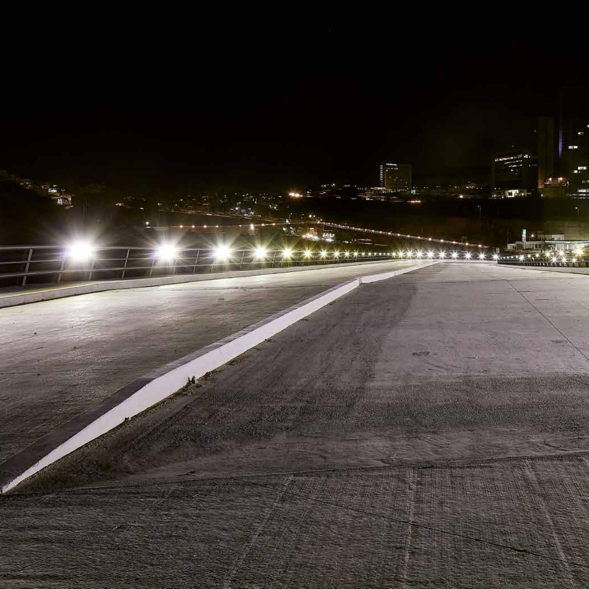
Luminario lineal diseñado para instalarse a baja altura en el parapeto de las vialidades.
